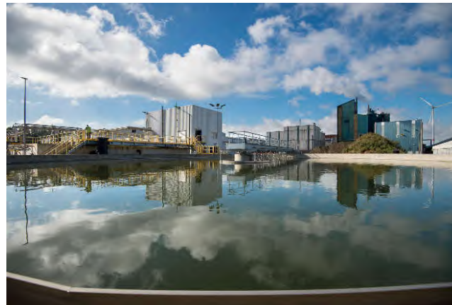
Waterzuiveringsinstallatie in Olen (Belgie)
